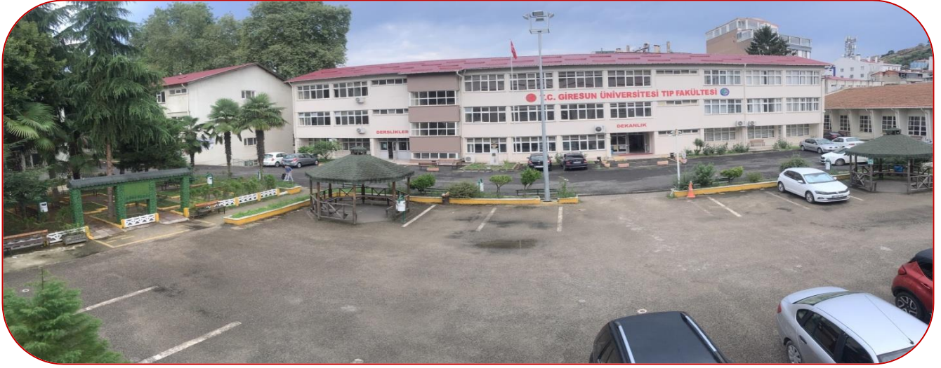
Fotoğraf- 3: Gazipaşa Yerleşkesi
