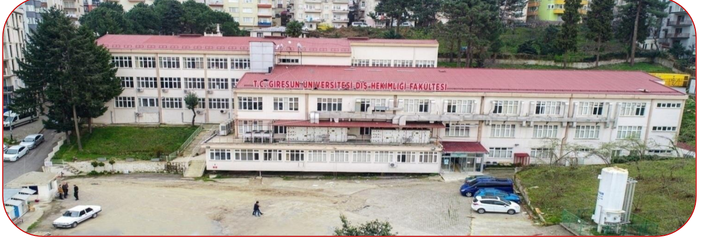
Fotoğraf- 4: Nizamiye Yerleşkesi-Dış Hekimliği Fakültesi
